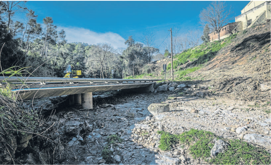
S'espera que les obres de millora de la gestió de l'aigua també acabin impactant a la riera de Cervelló, fotografiada ahir
