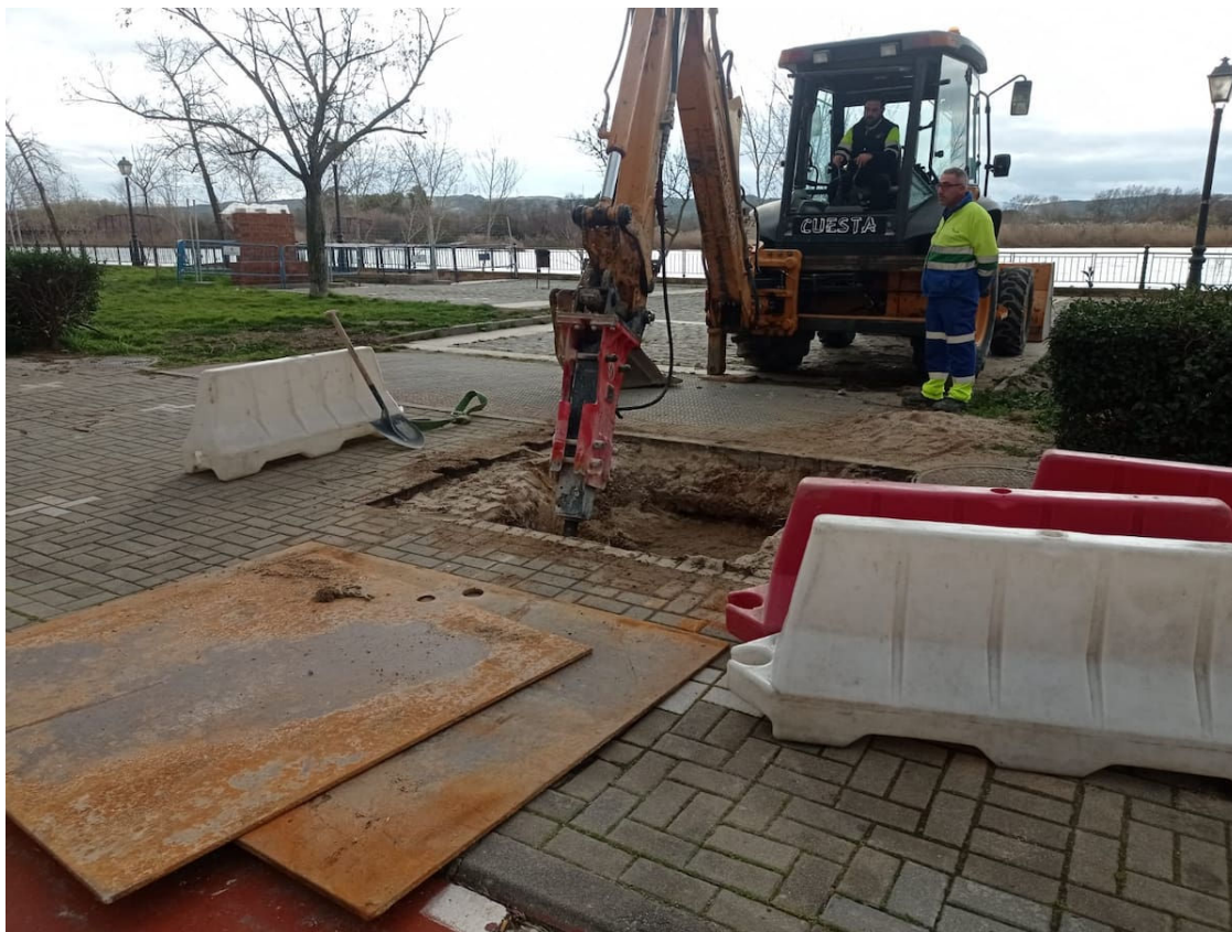
Maquinaria pesada trabaja en la ribera del Tajo, en la Ronda Sur de Talavera / Carlos Sánchez Jiménez
